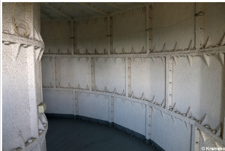
Korytarz na jednym z pięter
