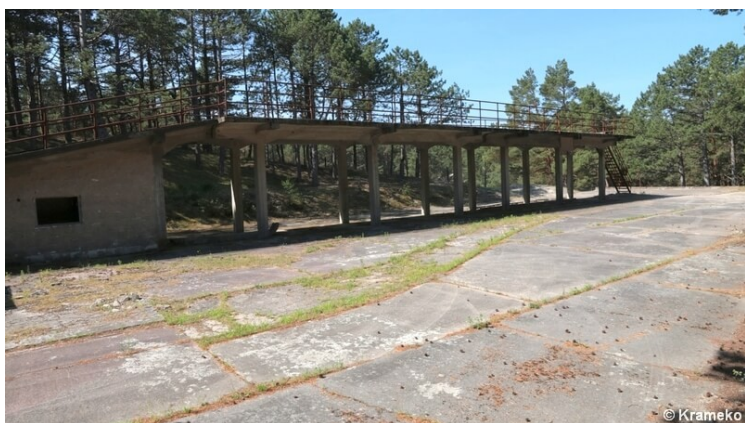
Betonowa płyta nakrywająca wielki schron (rampa powojenna)
